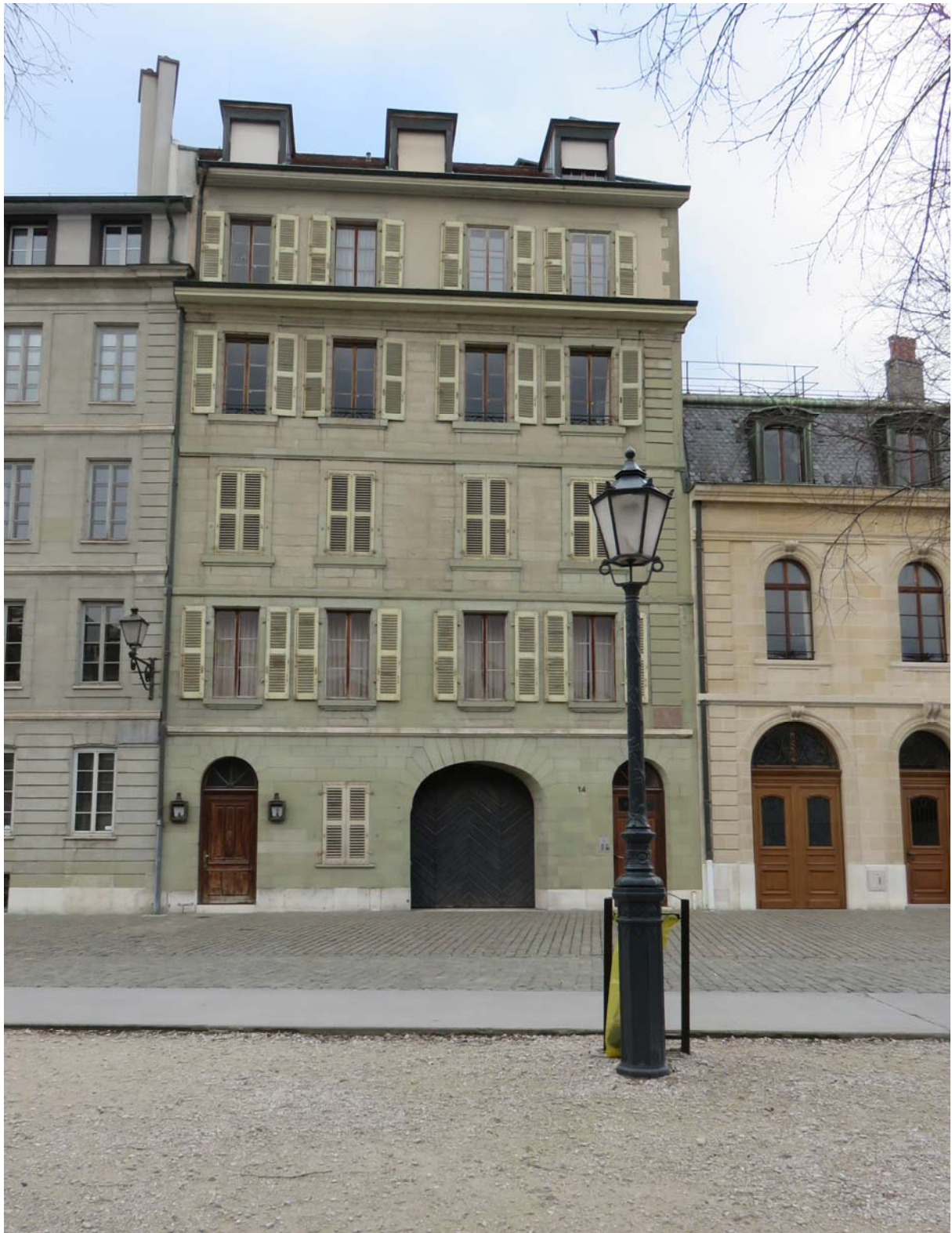
Les superbes façades des maisons bourgeoises de la rue Théodore de Bèze ou de ses environs immédiats.
